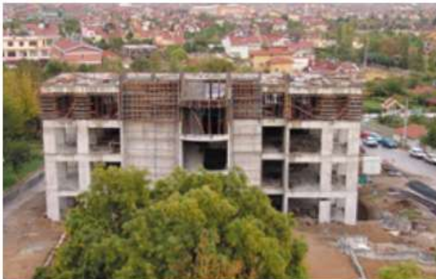
Yeni Onkoloji Hastanesi inşaatı
